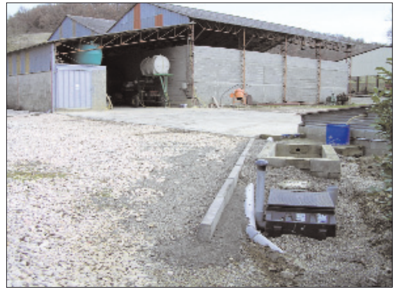
L'aménagement d'une aire étanche de remplissage et de lavage reliée à un lit biologique, est aidée à hauteur de 60 % (75 % en PAT).
