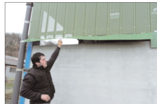
5 Un système d'ouverture à volets permet d'augmenter la ventilation du bâtiment lors de fortes chaleurs.
