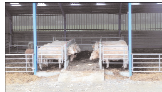
2 Couloir d'alimentation, (2 x 12 places aux cornadis) légèrement surélevé par rapport à la dalle d'auge (pied des animaux). Tout autour de la dalle d'alimentation, une dalle béton de 3 m au niveau du sol évite que le sol ne se creuse à cet endroit.
