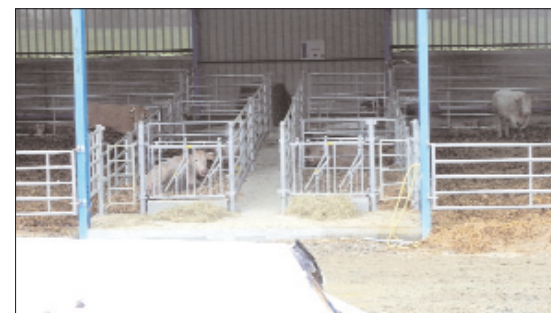
1 Travée centrale. Une surélévation de 20 cm du passage d'homme bétonné, facilite la surveillance.
