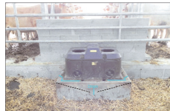
3 Abreuvoir. Le socle béton est incliné vers des bouches d'évacuation drainées afin de ne pas humidifier le pourtour de la litière.
