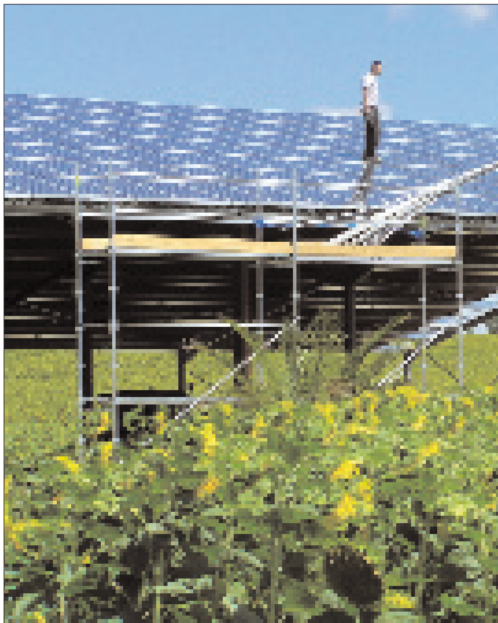
Installation photovoltaïque en cours de montage à Castelnau d'Arbieu.
