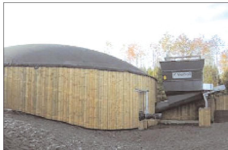
Un digesteur et sa trémie d'alimentation au GAEC Forget, dans les Ardennes (crédit photo : Agrikomp)
