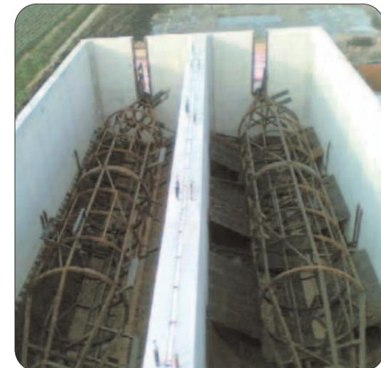
Construction d'un double digesteur de type OGIN à Zeewolde au Pays bas. On voit bien les rotors composés de tubes chauffants dans lesquels circule l'eau chaude du cogénérateur et équipés de pales qui brassent les matières en digestion. (source OGIN)
