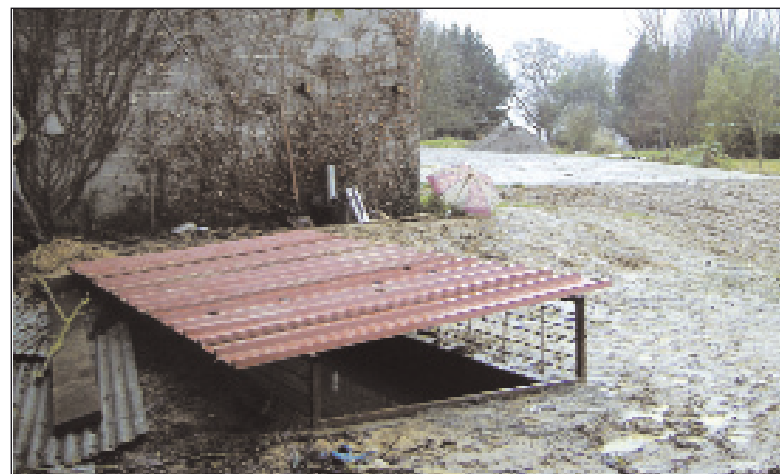
Aire de remplissage et lit biologique
