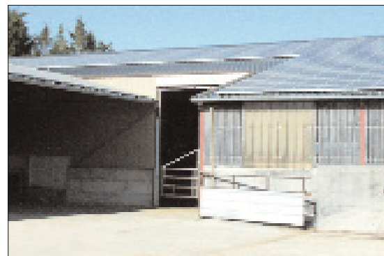
Stabulation pour vaches laitières, couverte avec un système intégré (bac acier + panneaux).
