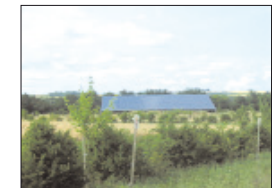
Bâtiment monopente couvert avec des panneaux photovoltaïques seuls.
