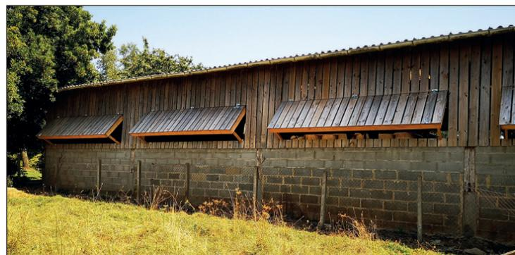
Une solution à moindre coût : ouvrir des trappes sur le bardage. (Source : CIRPO)
